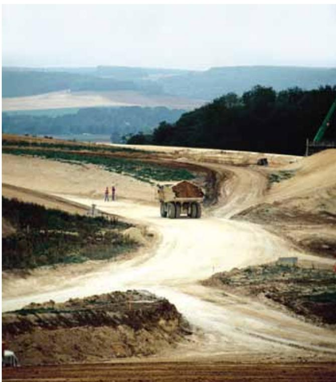
Angepasste Streckenverläufe der zu befahrenden Pisten verringern das Auftreten von dachförmigen Abriebsbildern.
