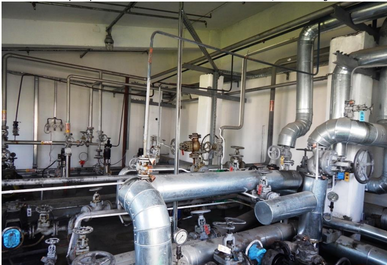
Statie pompe distributie solvent EXXSOL™ DSP 100/160 – imagine 1
