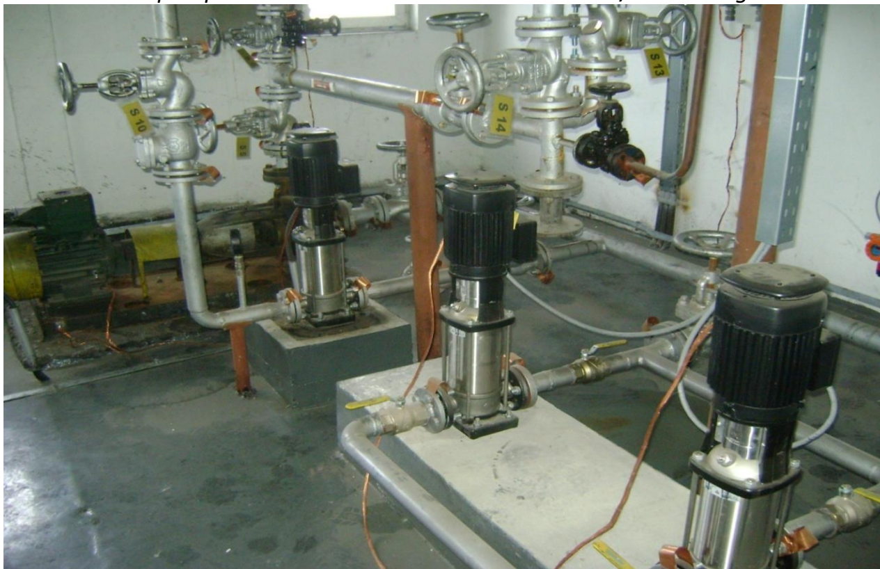
Statie pompe distributie solvent EXXSOL™ DSP 100/160 – imagine 2
